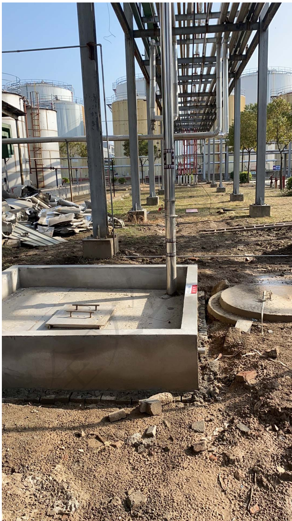
图 3.6-5 车间现状污水收集池
